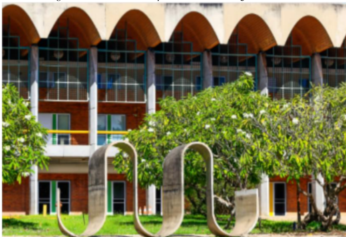
Figura 3 - Fachada sudoeste do prédio da Assembleia Legislativa do Piauí.
