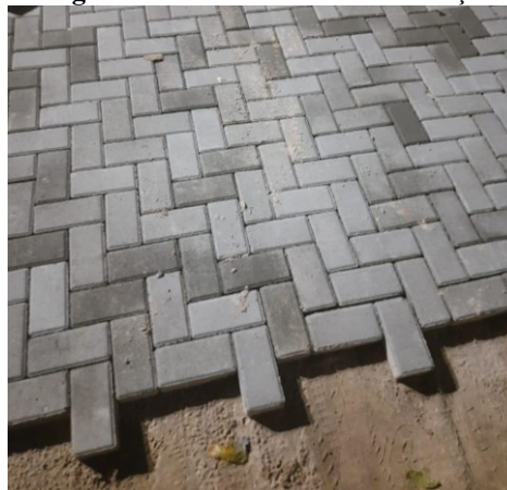
Figura 7 - Piso Intertravado da Praça
